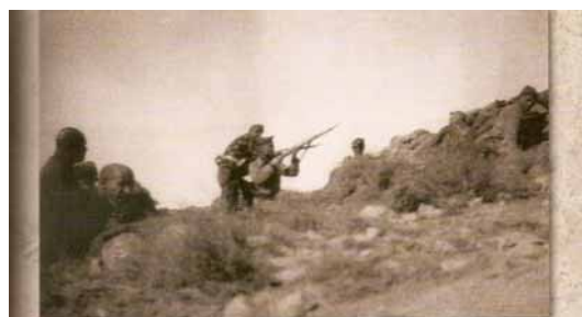
En las trincheras de Alcubierre, 1937 (Manuel Choy, Fototeca, DPH).
